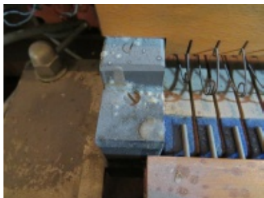
Sichtbare Schimmelflecken als Resultat zu hoher Feuchtigkeit
