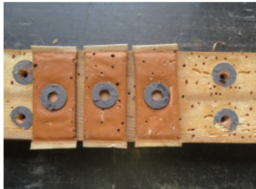
Detailansicht einer Membranleiste mit Ledermembranen, durchsetzt mit Wurmfraß. Somit war keine Funktion mehr gewährleistet. Dieser Missstand setzt sich in allen Manualen und Registern fort.
